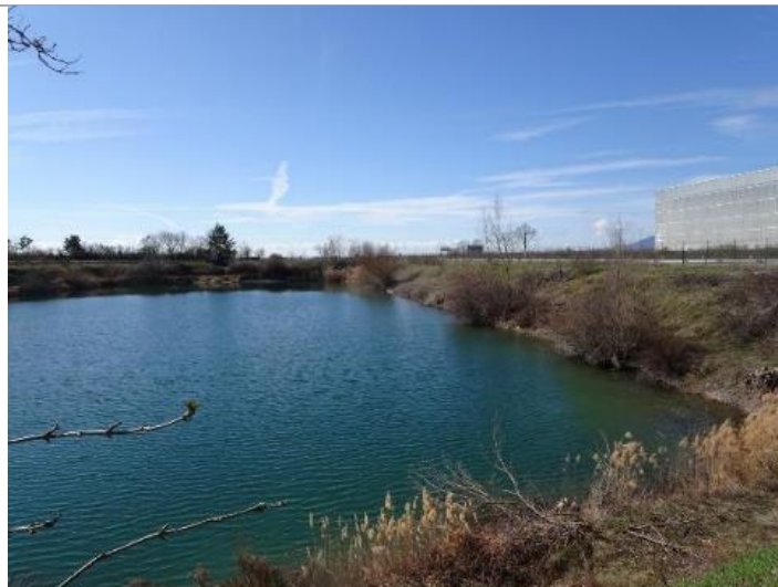
Bassin de rétention d'eau
