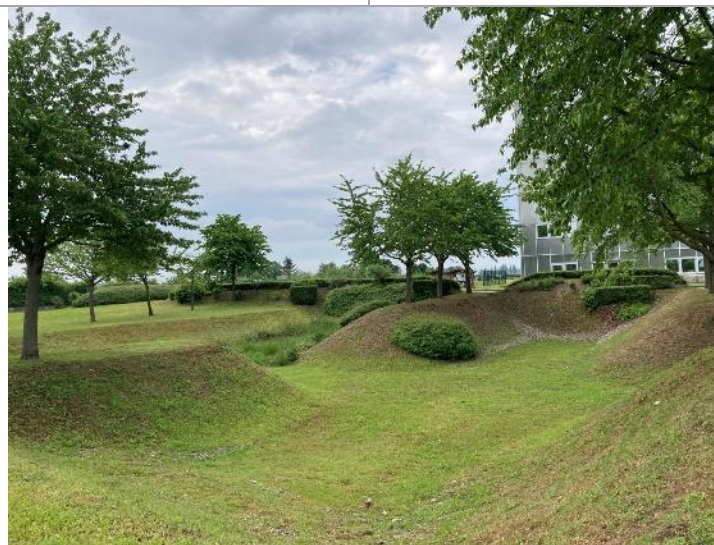
Bassin de rétention d'eau végétalisé (85)
