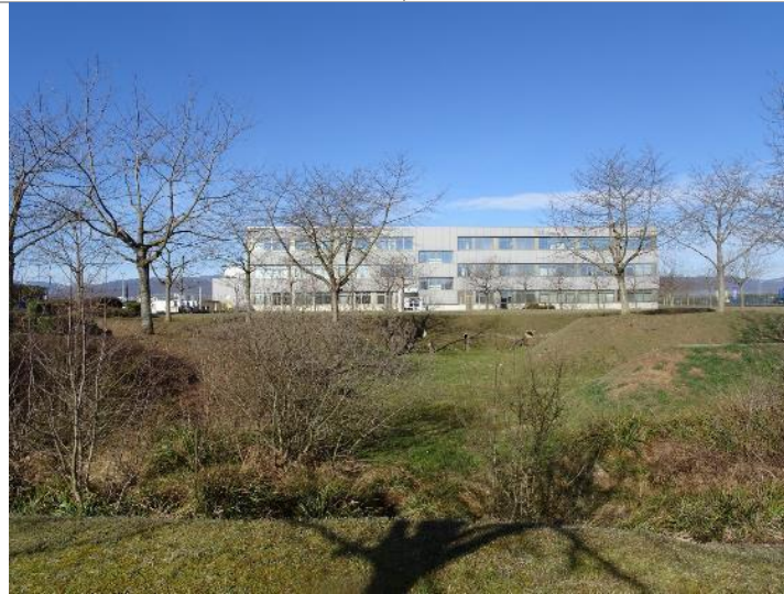
Bassin de rétention d'eau végétalisé (85)
