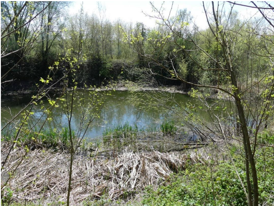
Figure 196 : L'un des deux bassins de la STEP non accessible (BEE Ing, avril 2022)
