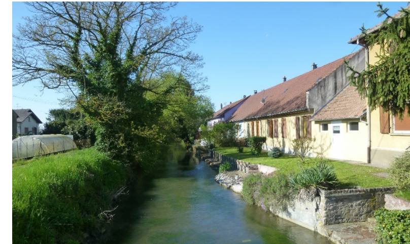
Figure 49 : Canal Vauban en traversée de Réguisheim
