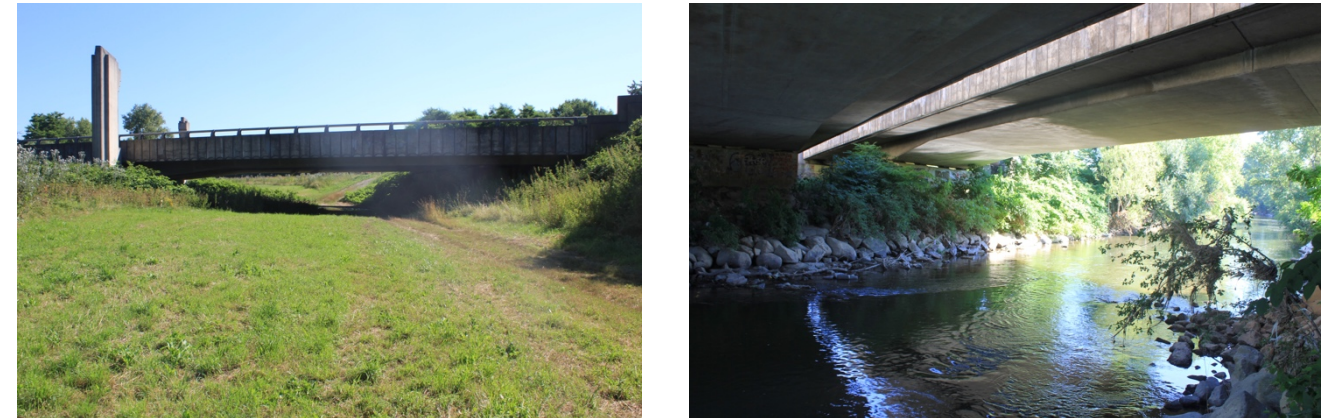
Figure 38 : vues des ouvrages de traversée de l'Ill à Meyenheim sous l'A35. On notera que les ouvrages sont suffisamment dimensionnés pour permettre une bonne transparence écologique de l'infrastructure routière.
