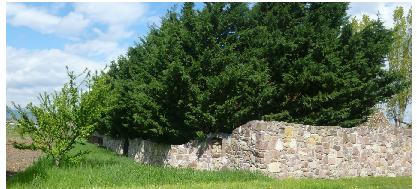
Figure 23 : Mur en pierres à Biltzheim
