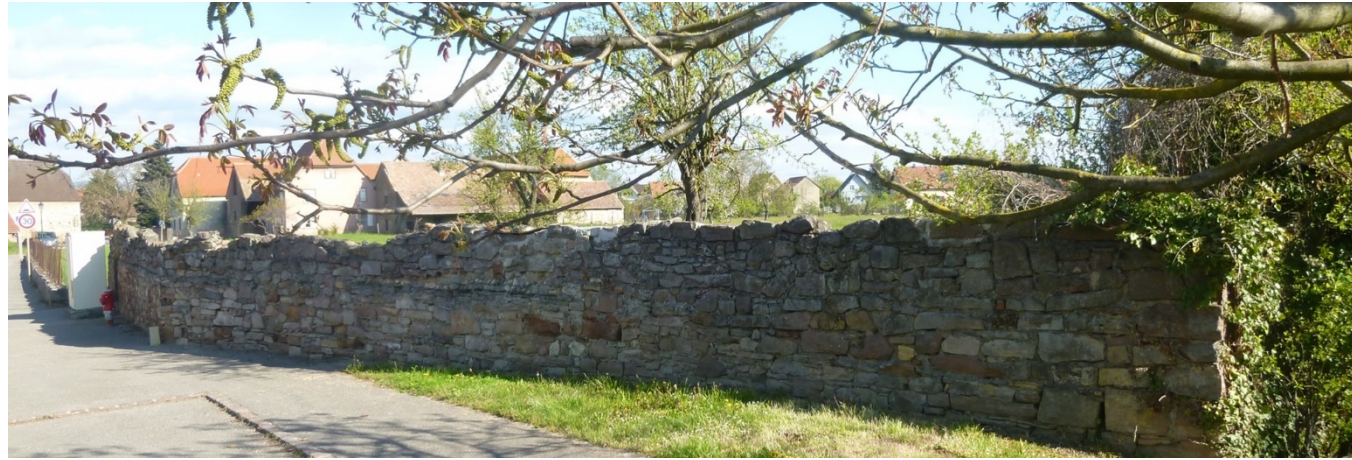
Figure 63 : Muret en pierres sèches à Réguisheim
