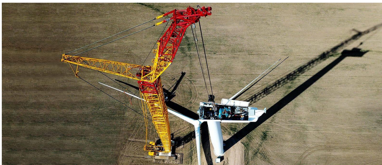
Figure 29 : Grue Liebherr de réparation pour éoliennes
