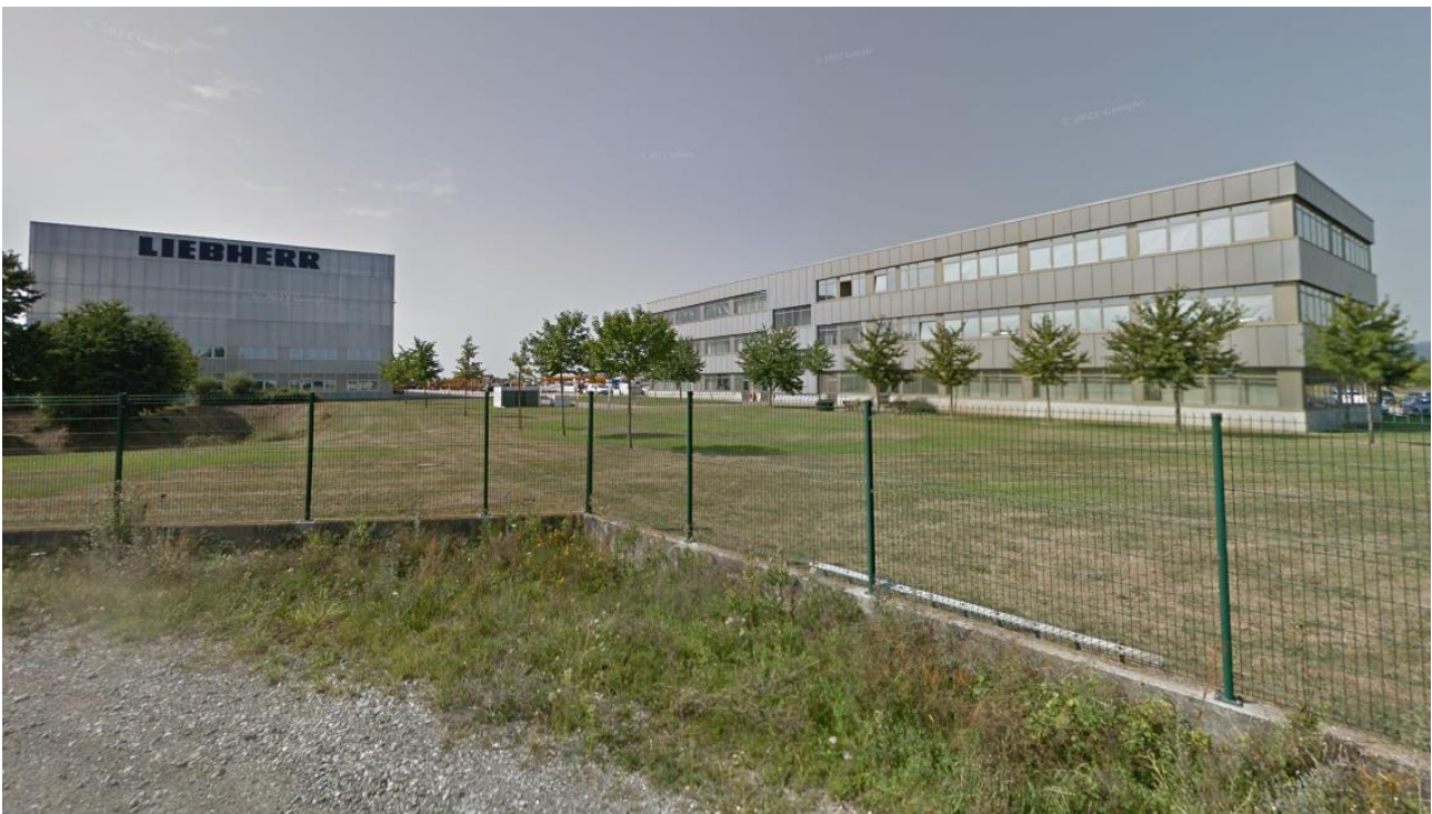
Figure 30 : Architecture des bâtiments Liebherr existants sur le site
